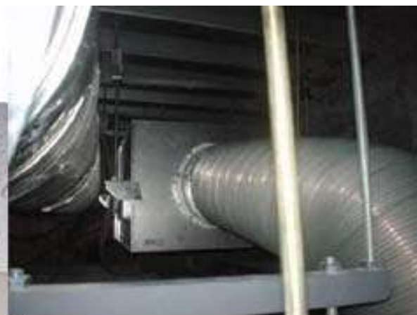
天井裏に排気装置を増設
