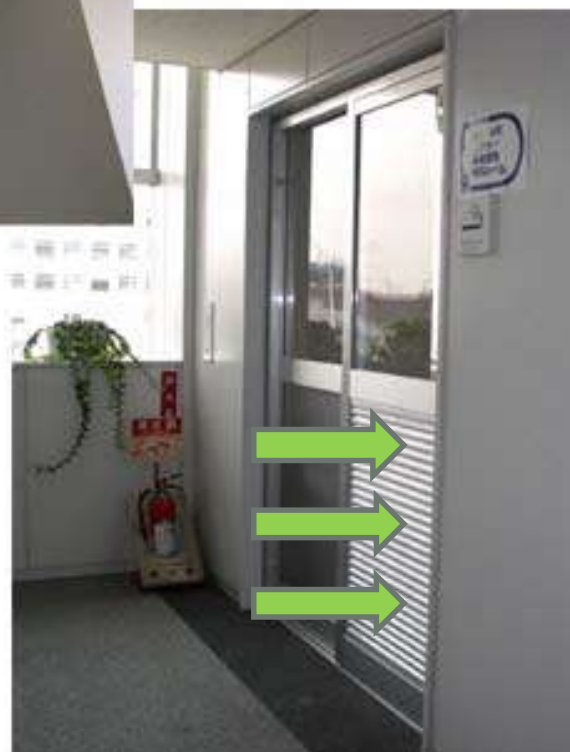
入り口にガラの設置
