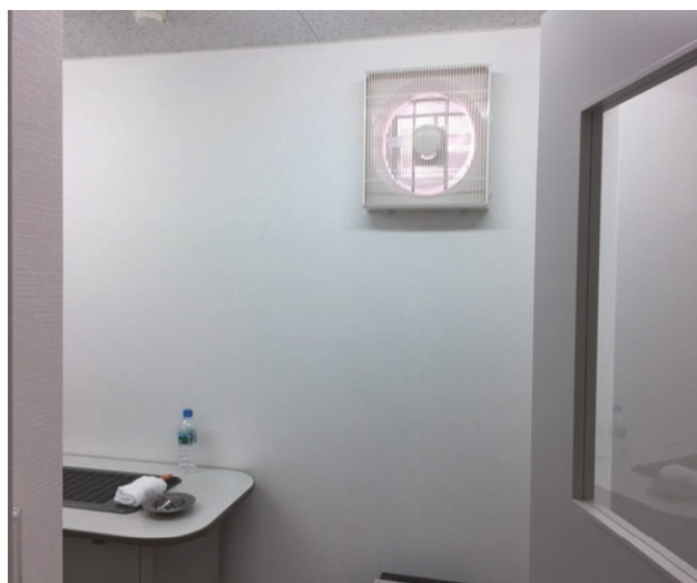
上 換気扇の設置
